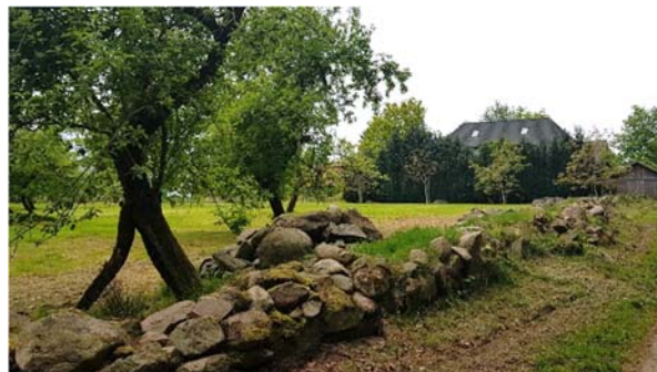
Abb. 4: Steinmauer (Blick von Südosten; Quelle: Elbberg, 16.05.2019)
